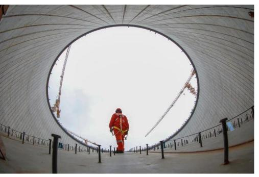
2月7日,从中国海洋石油集团有限公司获悉,粤 港澳大湾区首座全球单罐容量最大的27万立方米液化 天然气储罐在中国海油金湾"绿能港" 二期项目完成外罐主体结构施工作业, 全面转入内罐施工阶段,项目建成后将 大幅提升粤港澳大湾区和华南地区的 天然气供应保障能力。
